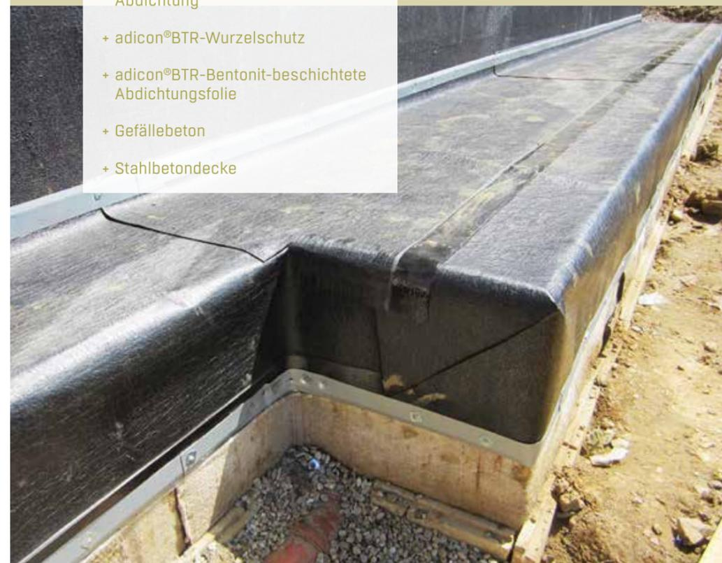
STABILE, GEWEBE-VERSTÄRKTE HDPE-FOLIE MIT EINER BESCHICHTUNG AUS NATÜRLICHEM NATRIUMBENTONIT.
