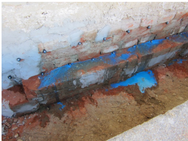
Man sieht im Zuge des Druckaufbaus ausgetretenes AC-Gel. Die Reaktion des Injektionsmaterials im Mauerwerk tritt unabhängig vom Feuchtegrad ein.
