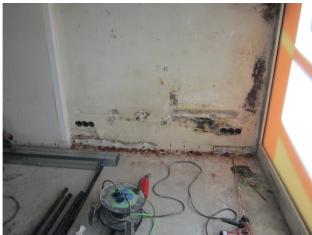
Herstellen der Bohrlöcher der 2-reihigen Bohrlochreihe.
