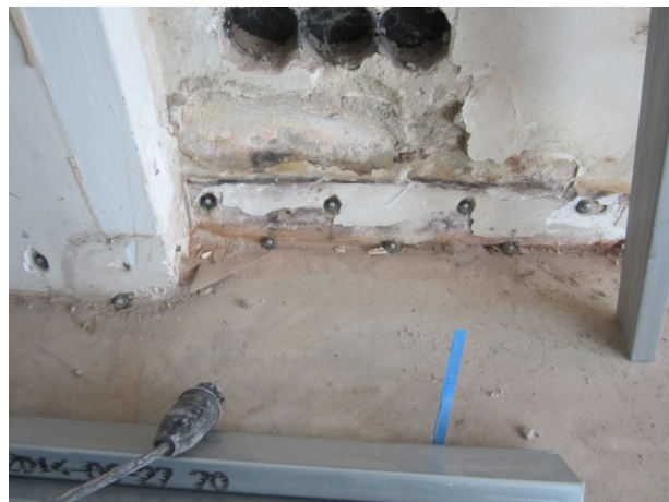
Speziell auf die Mauerwerkssituation abgestimmte Injektionspacker vor der AC-Gel Injektion.
