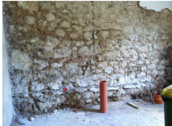
In einem ersten Schritt wird der alte Putz entfernt und die Wand sandgestrahlt. Dann wird eine Ausgleichsschicht als Verdämmmaßnahme hergestellt und mittels Rasterinjektion weichplastisches Acrylatharz in das Ziegelmauerwerk injiziert. Acrylatharz ist im injizierbaren Zustand annähernd so flüssig wie Wasser und verteilt sich im Mauerwerk daher sehr gut. Durch die kurze und einstellbare Reaktionszeit (15sec - 3min) gibt es kein „absitzen“ während der Abbindezeit.
