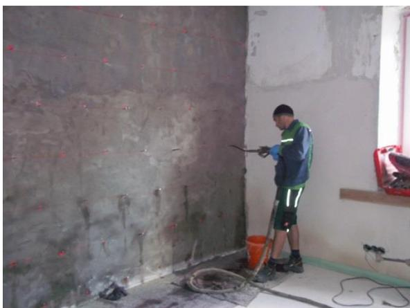
Die Reaktion des Acrylatharzes ist sowohl unabhängig vom Versalzungsgrad des Mauerwerks, als auch vom Durchfeuchtungsgrad. Aufwendige Vortrocknungen können entfallen.
