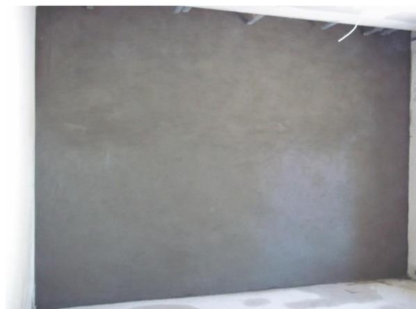
Anschließend wird eine sulfatbeständige Dichtschlämme in 2 Arbeitsgängen aufgebracht. Im Fußpunkt wird mit einer eingestemmtten Nut angeschlossen.
