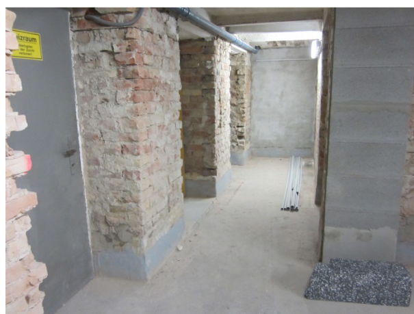
Fertiger Keller für untergeordnete Nutzung als Lagerkeller. Die Ziegelwände sind hydrophobiert.
