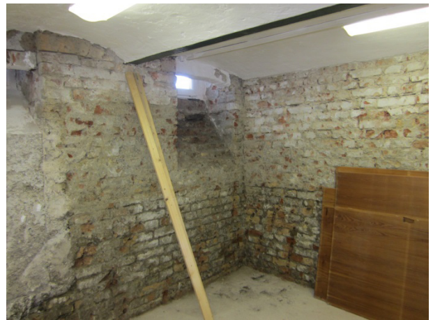
Abschlagen des Putzes ist jedenfalls erforderlich. Für die nachfolgenden Maßnahmen wird das Mauerwerk sandgestrahlt.
