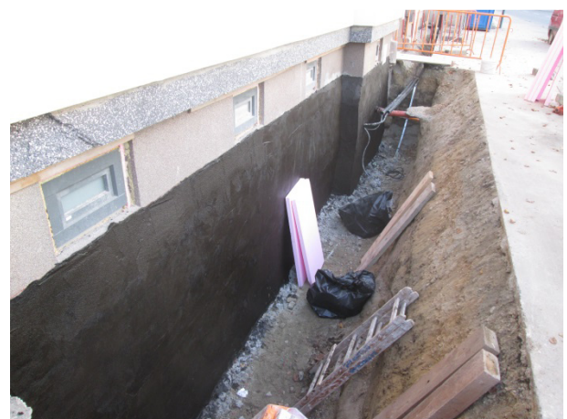
Außenabdichtung Strassenseite mit 2K-KMB Beschichtung 2-lagig mit Gewebeeinlage. Eine sorgfältige Untergrundvorbereitung des Bestandsmauerwerk ist wesentlich für den Abdichtungserfolg.
