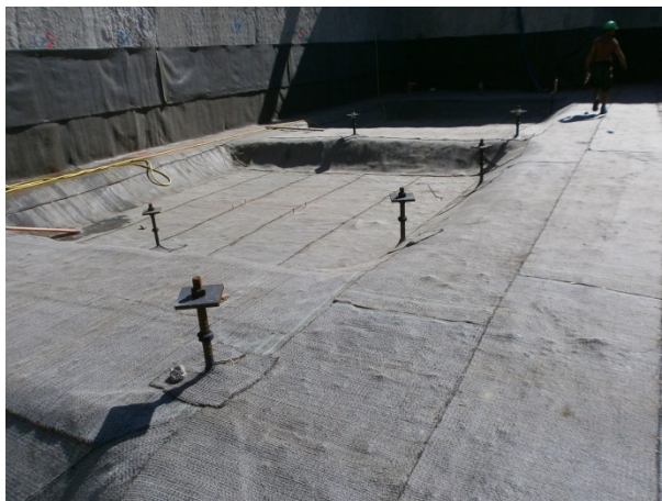
Einbindung der Zugpfähle (Sicherung des Gebäudes gegen Auftrieb) in der Bodenplatte mit Bentonitquellbändern und Verstärkungslage.
