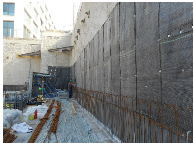
Montage der Bentonitmatten als Vertikalabdichtung direkt auf der Schlitzwand.
