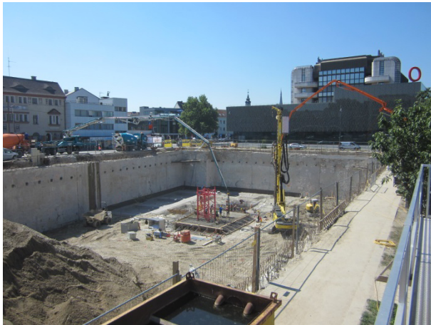
Baugrube mit Schlitzwand 60cm als Baugrubensicherung.
