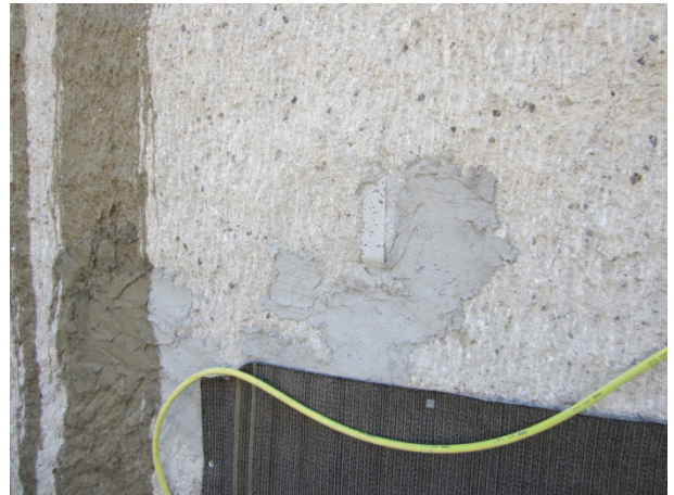
Eine Untergrundvorbereitung der Schlitzwand bei größeren Ausbrüchen und dergleichen ist bei Bedarf erforderlich.
