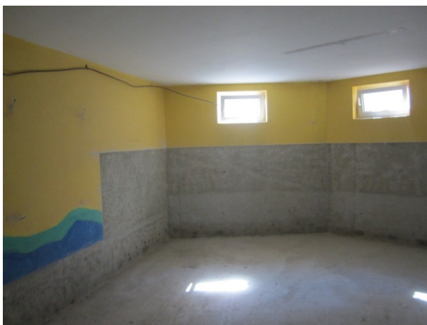
Bestandskeller (Stahlbeton) nach den Abbrucharbeiten (Fußbodenaufbau und Wandinnenputz).
