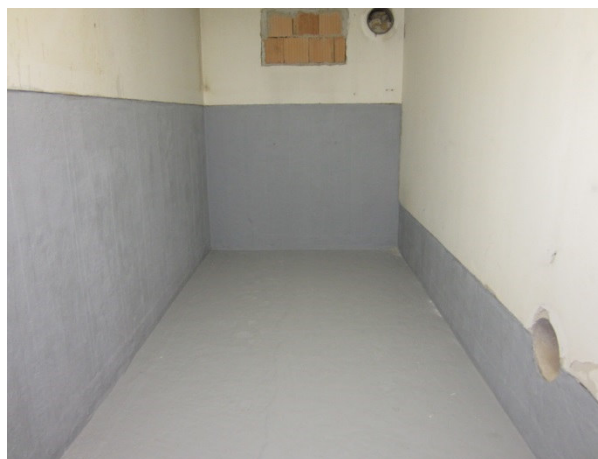
Fertige Innenabdichtung. Hochzüge Innenwände: 50cm Hochzüge Außenwände: 150cm
