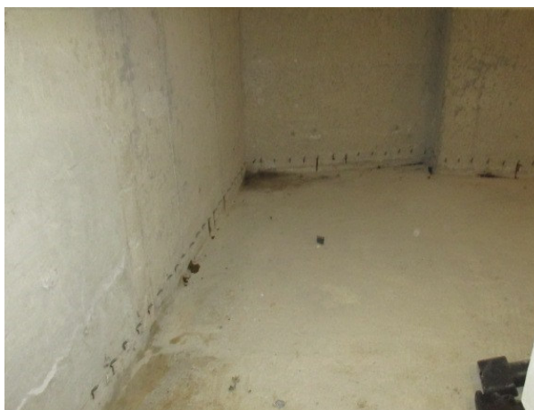
Abdichtung der Boden-/Wandfuge mittels 2K-PU-Harz-Injektion als erste Abdichtungsmaßnahme.
