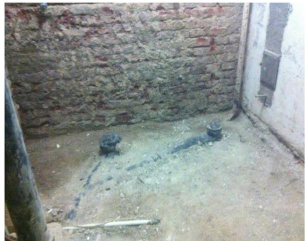
In einem ersten Schritt wird der alte Putz entfernt und die Wand sandgestrahlt. Dann wird eine Ausgleichsschicht als Verdämmmaßnahme hergestellt und mittels Rasterinjektion weichplastisches Acrylatharz in das Ziegelmauerwerk injiziert. Acrylatharz ist im injizierbaren Zustand annähernd so flüssig wie Wasser und verteilt sich im Mauerwerk daher sehr gut. Durch die kurze und einstellbare Reaktionszeit (15sec - 3min) gibt es kein „absitzen“ während der Abbindezeit.
