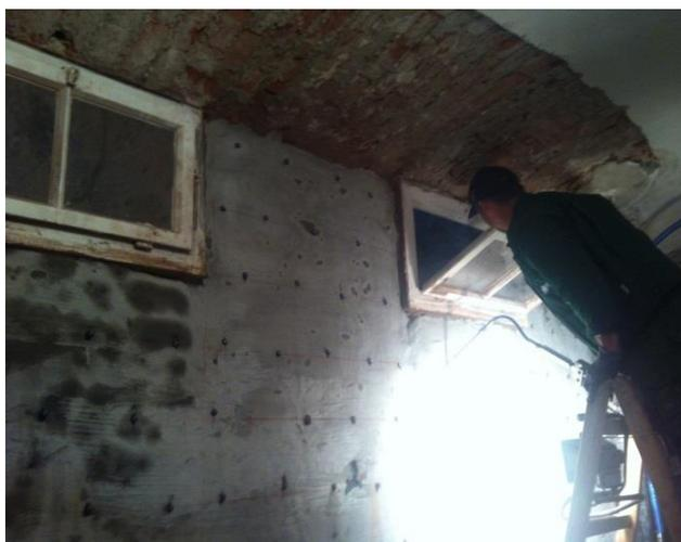
Die Reaktion des Acrylatharzes ist sowohl unabhängig vom Versalzungsgrad des Mauerwerks, als auch vom Durchfeuchtungsgrad. Aufwendige Vortrocknungen können entfallen.
