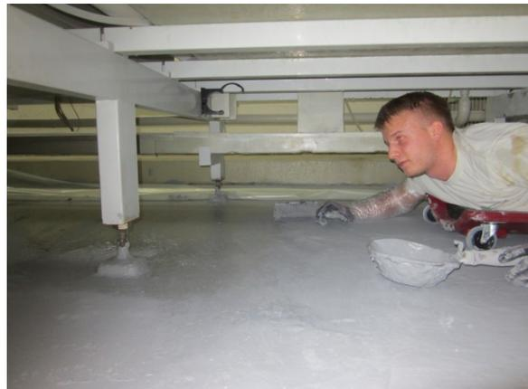
Die bestehende Beschichtung wurde entfernt und adicon SILAT wird in 2 Arbeitsgängen aufgetragen.
