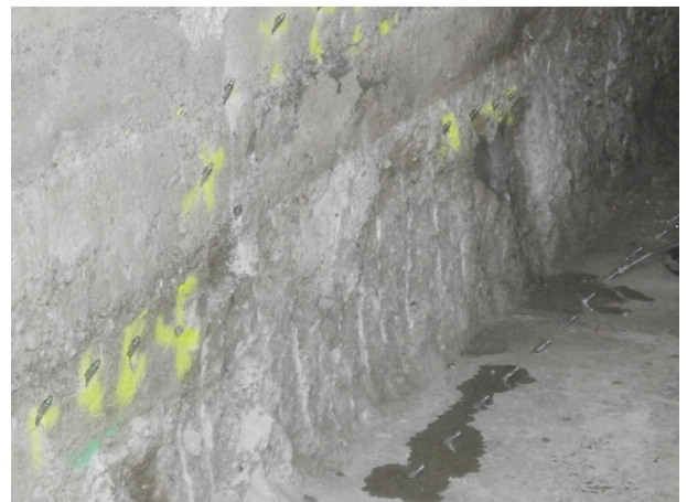
Anordnung der Bohrpacker für die Injektionen der einzelnen Fugen und Risse.
