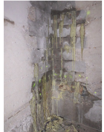
2K-PU-Harz Injektionen zum Stoppen der Wassereintritte vor Herstellen der Negativabdichtung.
