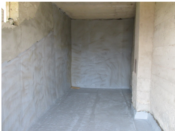
Negativwanne mit ADICON lamin DS als Flächenabdichtung gegen Wasserdruck bis 0,5bar (5m Wassersäule). Fertig für den Innenausbau der neuen Wohnräume.
