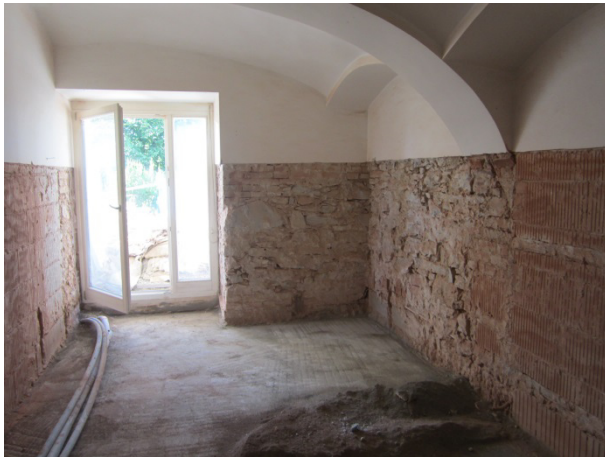
Rückbau der gesamten Wohnung in den Rohbauzustand.
