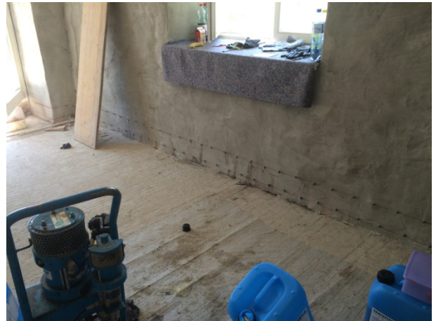
Horizontalsperre (Bohrlochreihe 2-reihig) mit AC-Gel an der Außenwand auf 2 Horizonten.
