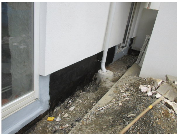
Anbindung der Portale mit ADICON lamin DS und Sockelabdichtung mit 2K-KMB Beschichtung 2-lagig mit Gewebeeinlage.
