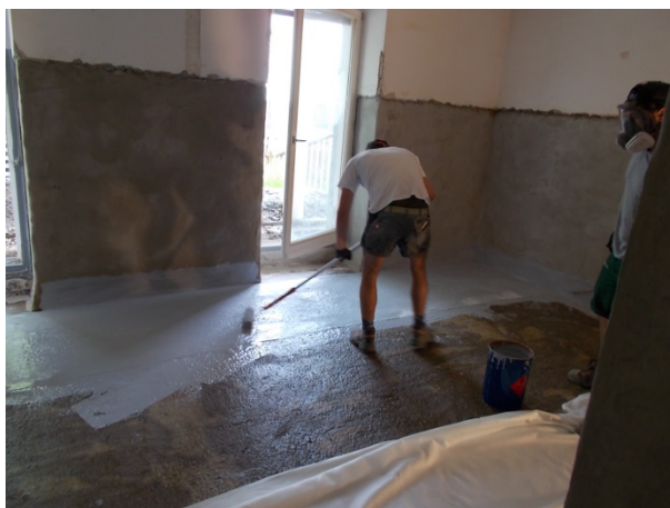
ADICON lamin DS als Flächenabdichtung gegen negativen Wasserdruck bis 0,5bar (5m Wassersäule) auf der Bodenplatte.
