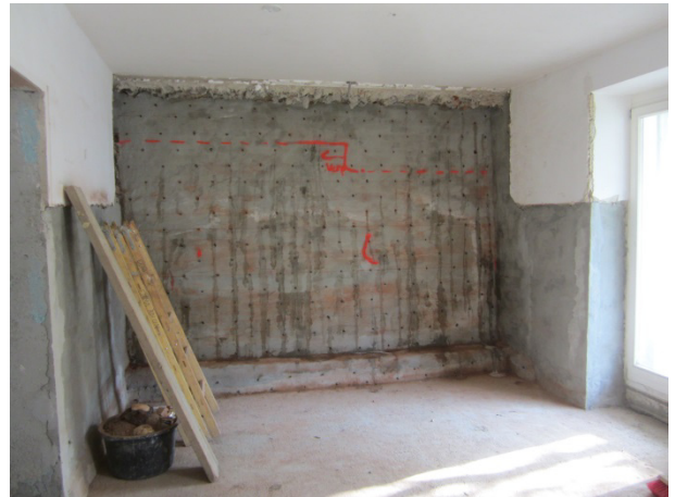
Schleierinjektion bei der hangseitig eingeschütteten Außenwand.
