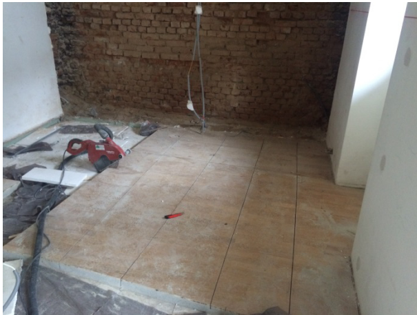
Rückbau der gesamten Wohnung in den Rohbauzustand.
