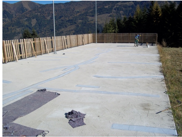
Streifenförmige Herstellung der Dichtbandage mit Untergrundvorbehandlung, Grundierung, Dichtbandage und UV-Versiegelung.
