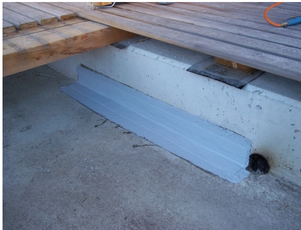
Die Dichtbandage ADICON lamin DS passt sich perfekt dem Untergrund an und geht eine dauerhafte Verbindung mit dem Betonuntergrund ein.
