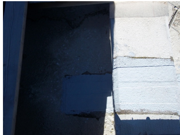
Streifenförmige Herstellung der Dichtbandage mit Untergrundvorbehandlung, Grundierung, Dichtbandage und UV-Versiegelung.
