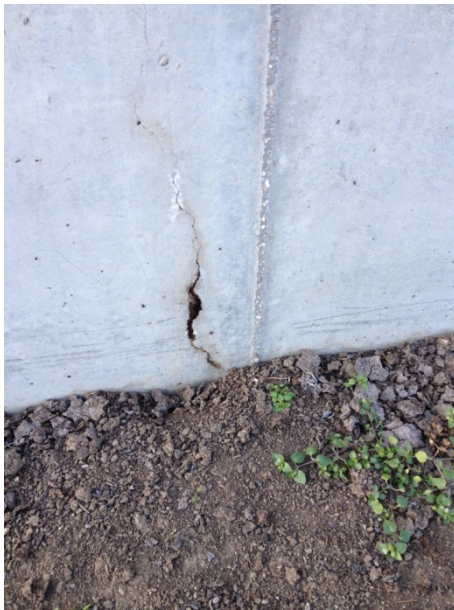
Schadensbild: Austritt von eingelagerter Gülle über Risse im Stahlbeton.
