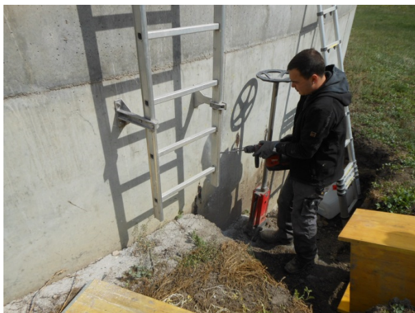
Schadensbild: Austritt von eingelagerter Gülle über Risse im Stahlbeton.
