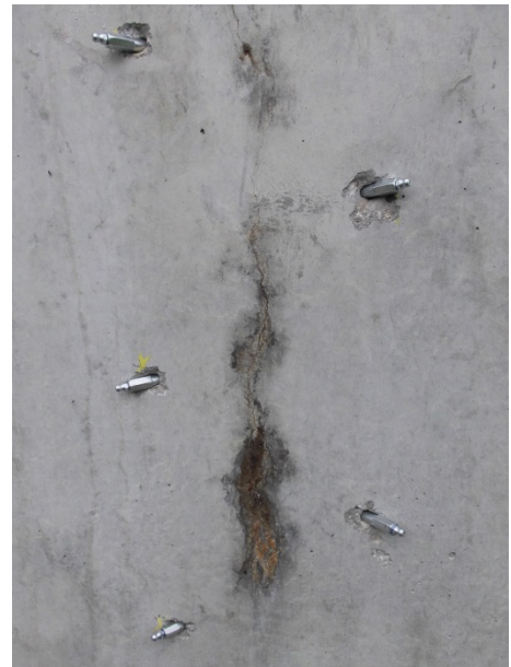
Fachgerechtes Setzen von Bohrpäckern zur nachfolgenden Rissinjektion mit 2K-PU-Harz.
